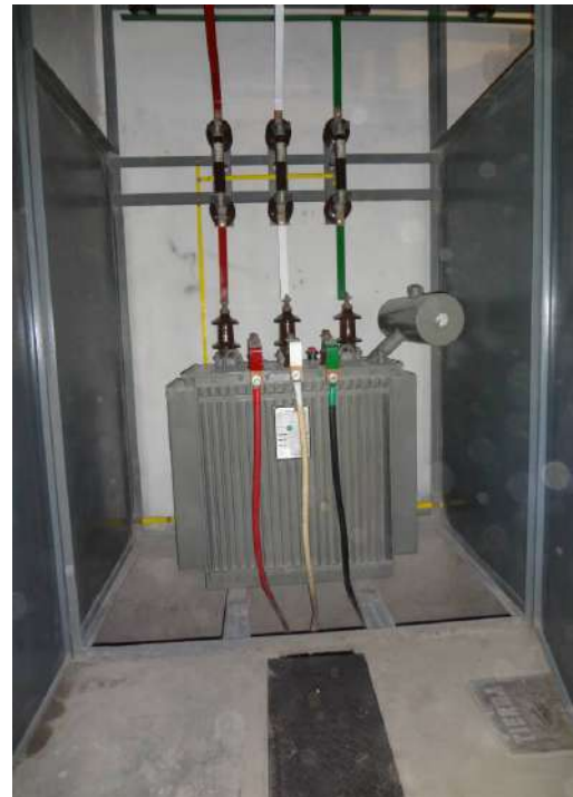
Mantenimiento de Celda de Llegada y Transformación 10KV
