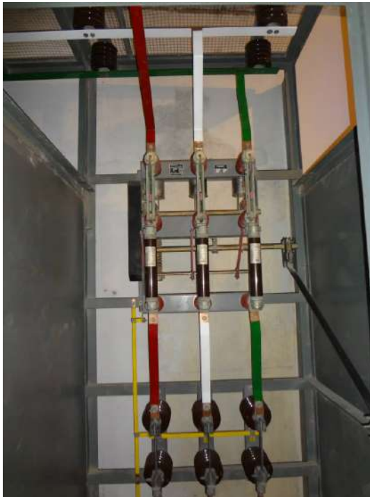
Mantenimiento de Celda de Llegada y Transformación 10KV
