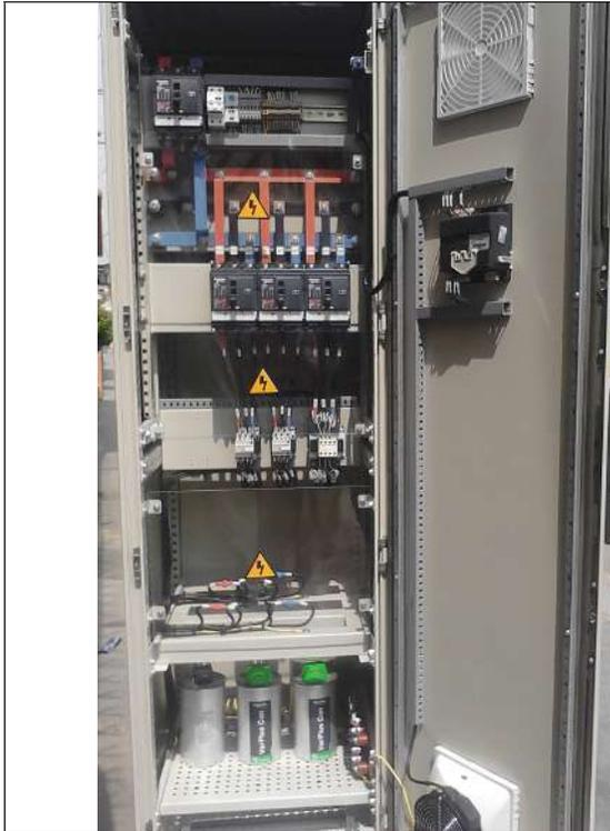
Foto N° 05 - Tablero de Banco de Capacitores Automático
