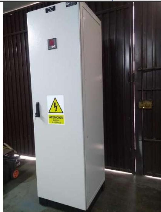
Foto N° 11 - Tablero de Banco de Capacitores Automático
