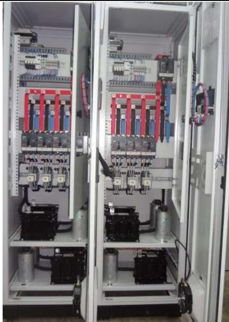
Foto N° 08 - Tablero de Banco de Capacitores Automático
