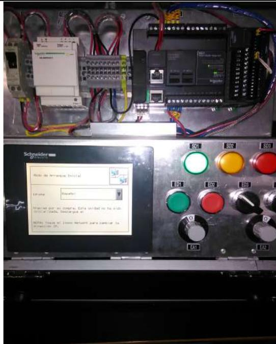
Foto N° 12 - Tablero de Banco de Capacitores Automático
