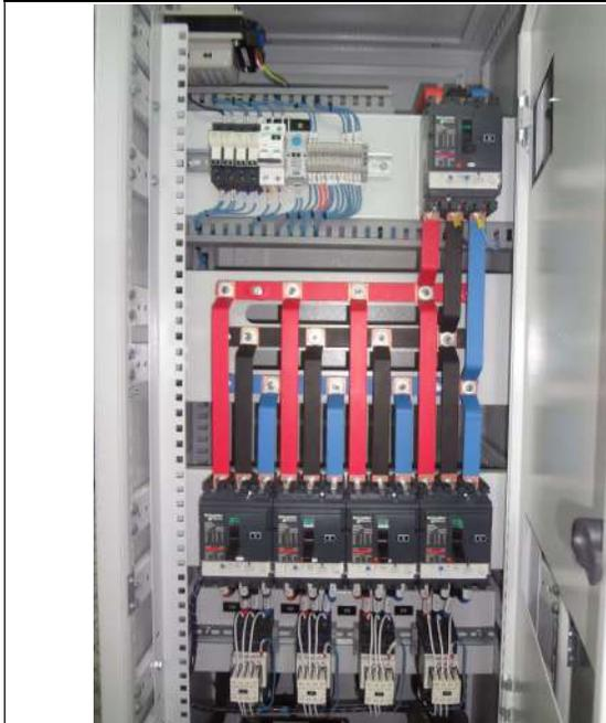
Foto N° 07 - Tablero de Banco de Capacitores Automático
