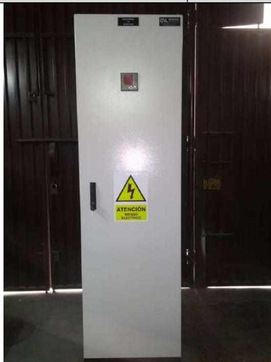
Foto N° 12 - Tablero de Banco de Capacitores Automático
