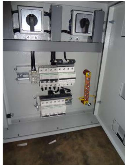
Foto N° 02 - Tablero de Transferencia Manual y de Distribución
