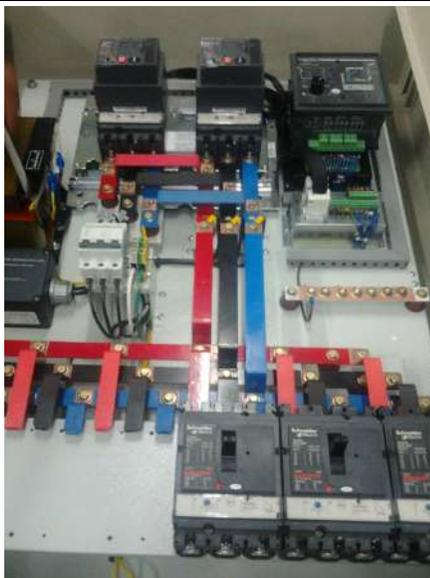
Foto N° 01 - Tablero de Transferencia Automática
