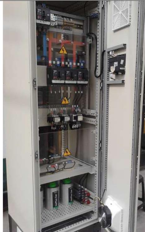
Foto N° 06 - Tablero de Banco de Capacitores Automático
