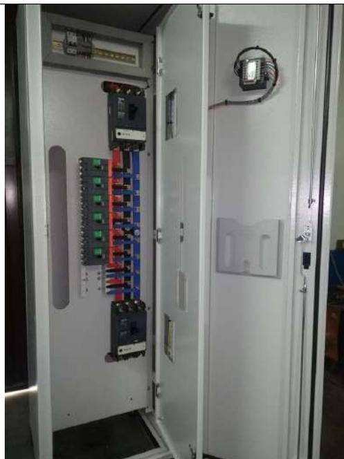
Foto N° 10 - Tablero de Banco de Capacitores Automático
