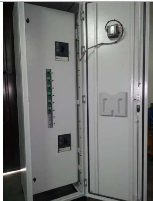
Foto N° 09 - Tablero de Banco de Capacitores Automático
