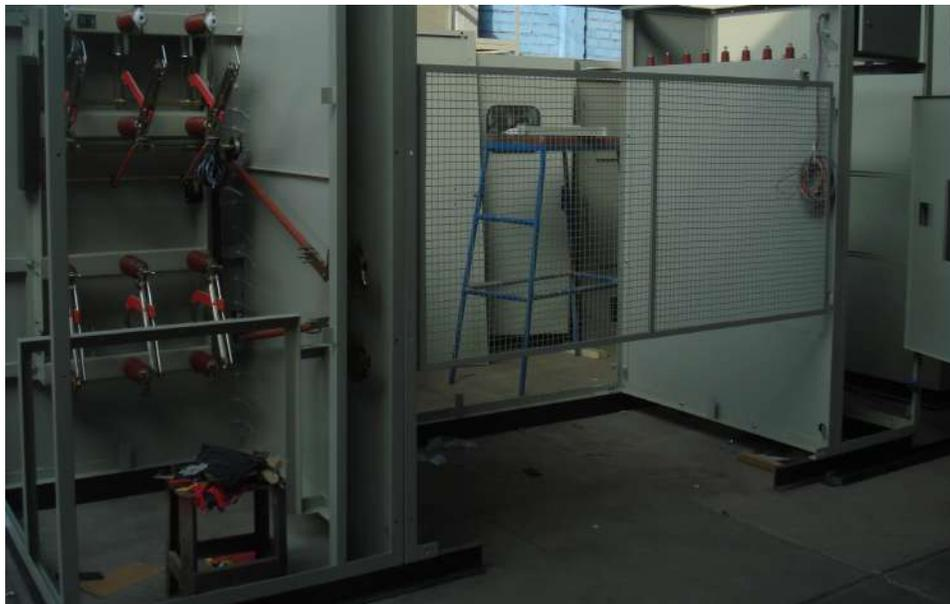
***Sub Estación Eléctrica Compacta 400kVA, 24kV, con Celda de Llegada, Transformación***
