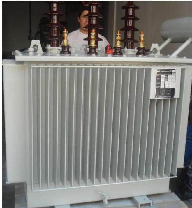
***Transformadores de distribución de 50kVA, 22.9kVA***
